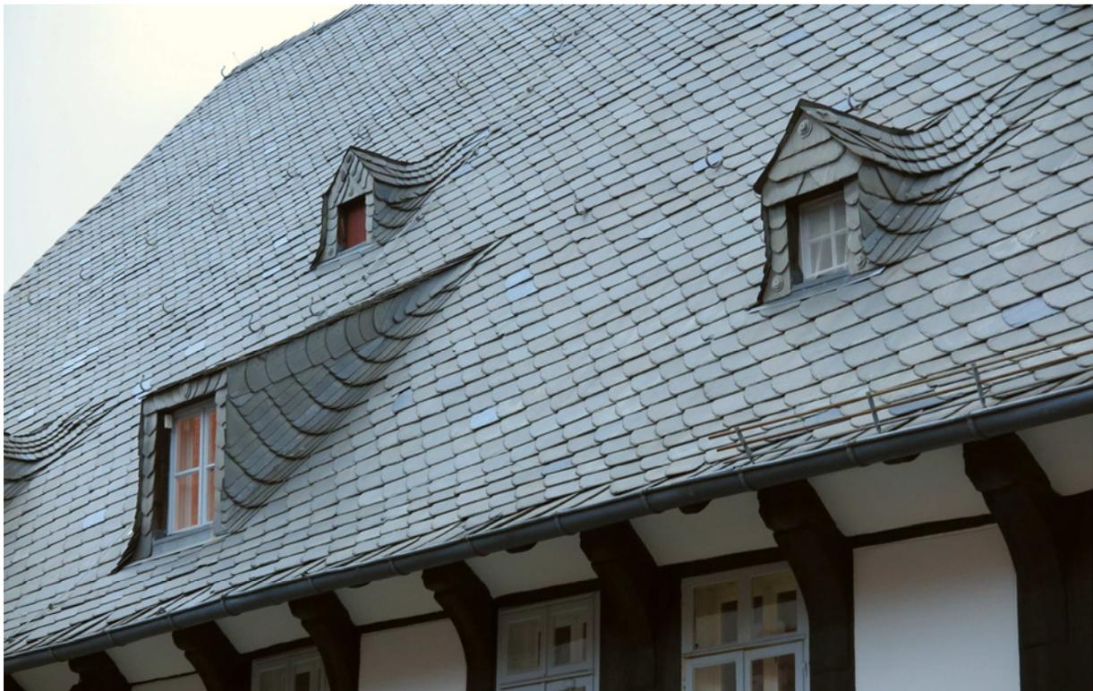
**Abb. 17b:** Großes Heiliges Kreuz in Goslar: Dachfläche mit steigenden Gebinden in Altdeutscher Deckung. Senkrechte Flächen der Dachaufbauten werden durch Kehlen fließend an die Dachfläche angeschlossen, was an die Schuppenhaut einer Echse erinnert.
