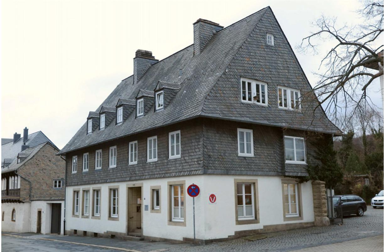
**Abb. 17a:** Wie eine Haut überzieht Dachschiefer die Wand-, Giebel- und Dachflächen mitsamt Zwerchhäusern und Schornsteinen des Eckhauses in der Glockengießerstraße/Goslar. Waagerechte Gebinde gliedern die Wandflächen, während die Dachflächen sowie die Giebeldreiecke, die im Traufbereich mit einem Pultdach abschließen (sogenannte „Goslarer Giebel“), steigende Gebinde zeigen. Lediglich das (verputzte) Erdgeschoss ist unverkleidet.
